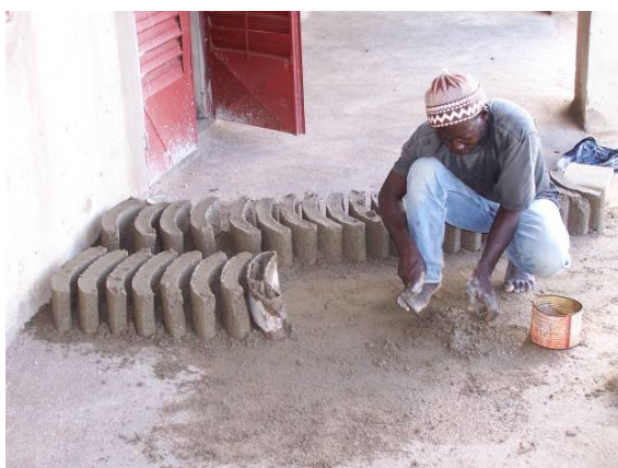
Fabrication des briques
