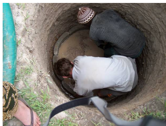
Pose des briques
