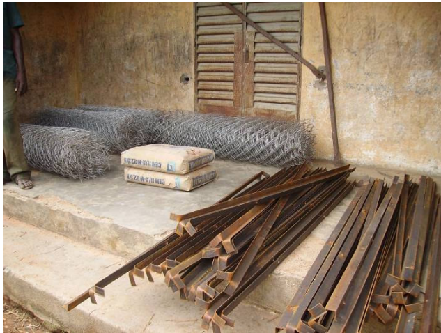
Grillage, piquets et ciment
