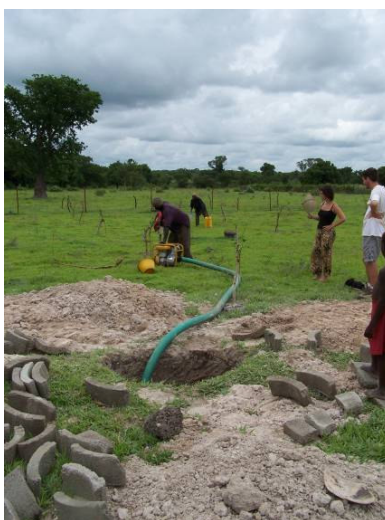
Pompage de l'eau du puit
